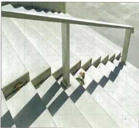
宽楼梯中间栏杆扶手
