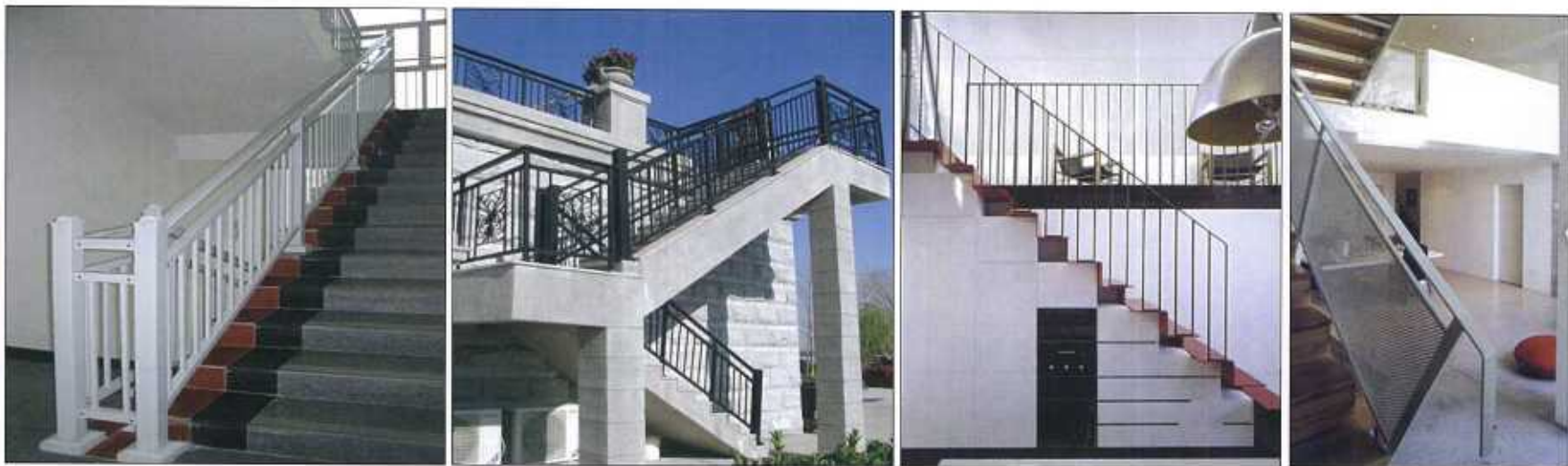
室内楼梯栏杆栏板
